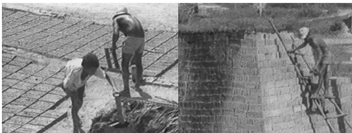
Imagem 9 e 10: Autoria desconhecida. Os adobes e tijolos eram postos para secar ao sol, logo empilhados em pirâmide para a queima. Quadro do documentário “Olarias: Uma História Marcada”. Disponível no Youtube e Acervo Público do Estado do Piauí.
